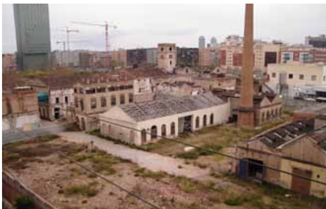
Nach langen Konflikten konnten einige Gebäude des historischen Fabrikkomplexes Can Ricart erhalten werden. Die Anlage steht inzwischen unter Denkmalschutz und wird künftig verschiedene kulturelle Einrichtungen beherbergen. Foto: Albert García Escuder
