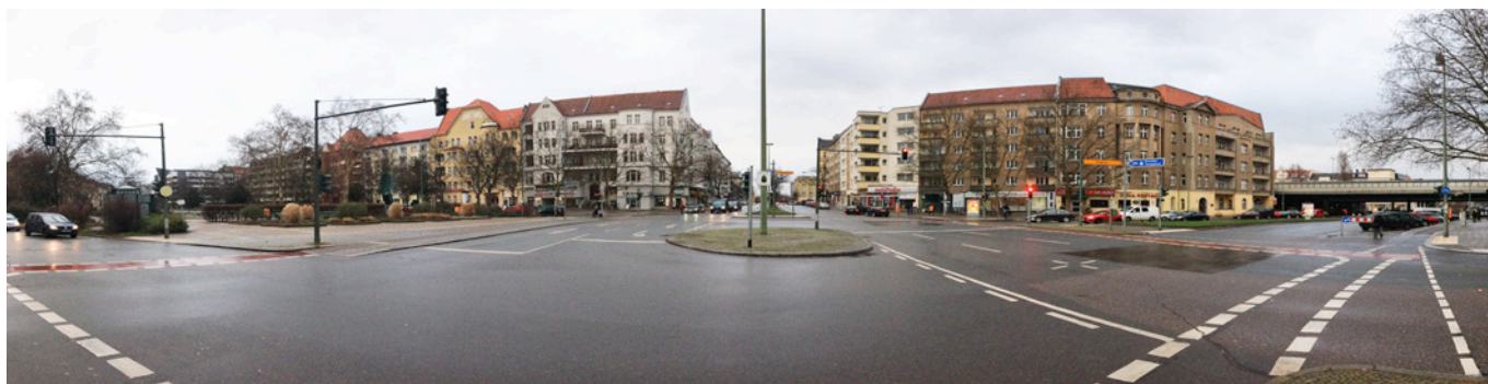
Überdimensionierte Verkehrsflächen und wenig oder nicht nutzbare Räume wie die Mittelinsel prägen die Kreuzung der Bundesallee mit der Wex- und Detmolder Straße am Bundesplatz.
