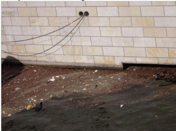
**Bild 3** Einleitungsstelle für ungeklärtes Abwasser im Regierungsviertel
